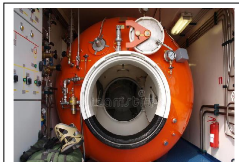
Fig. 53 – TSP/P Câmara de descompressão uma Unidade Offshore
