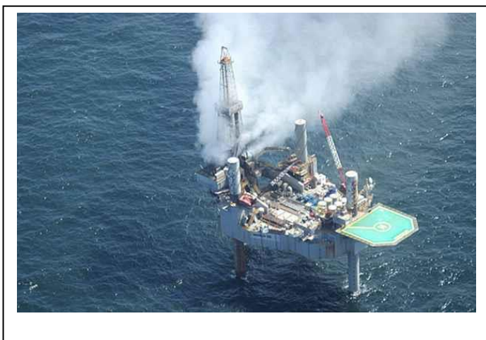
Fig. 6 TSP/P – Vazamento de gás
