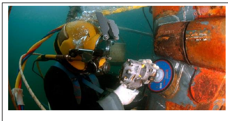
Fig. 41 – TSP/P Plataforma com mergulhador em operação
