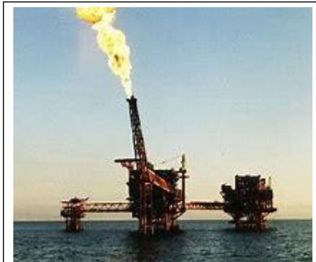
Fig. 52– TSP/P Queimadores uma Unidade Offshore
