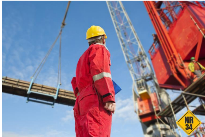
Fig. 34 – MOVIMENTAÇÃO DE CARGA
